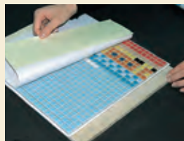
②並べたタイルの上にタック シートを貼る
