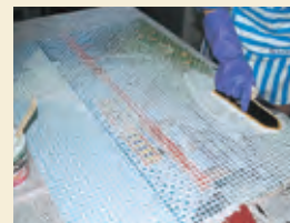
⑤目地材を目地に詰めて仕上 げる
